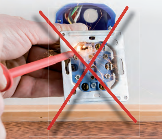
Hálózatra kapcsolt készülék szerelése életveszélyes és tilos!
